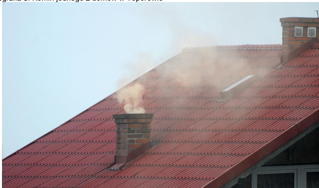
Fotografia 6. Komin jednego z domów w Toporowie
