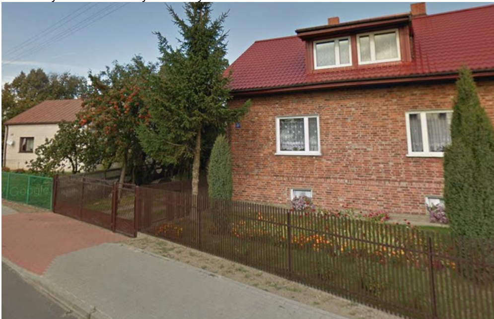
Fotografia 7. Budynek mieszkalny w Mierzycach
